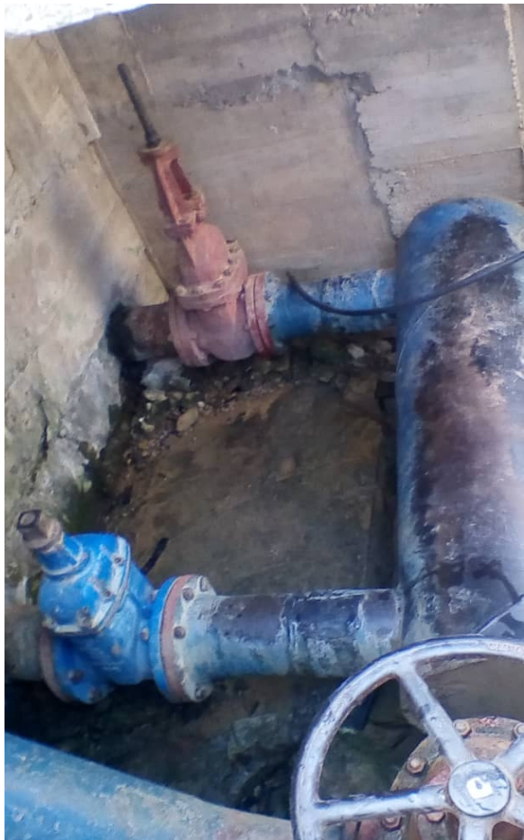
Cuerpo de válvulas de entrada y salida del tanque
