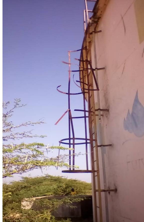
Escalera de acceso presenta daños en los peldaños y la estructura de protección.
