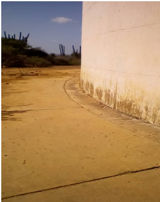
Desnivel en la parte inferior del tanque que amerita una inspección profunda para determinar si es un hundimiento
