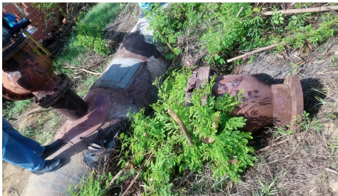
Ventosa 10" Removida para instalación del By-Pass
