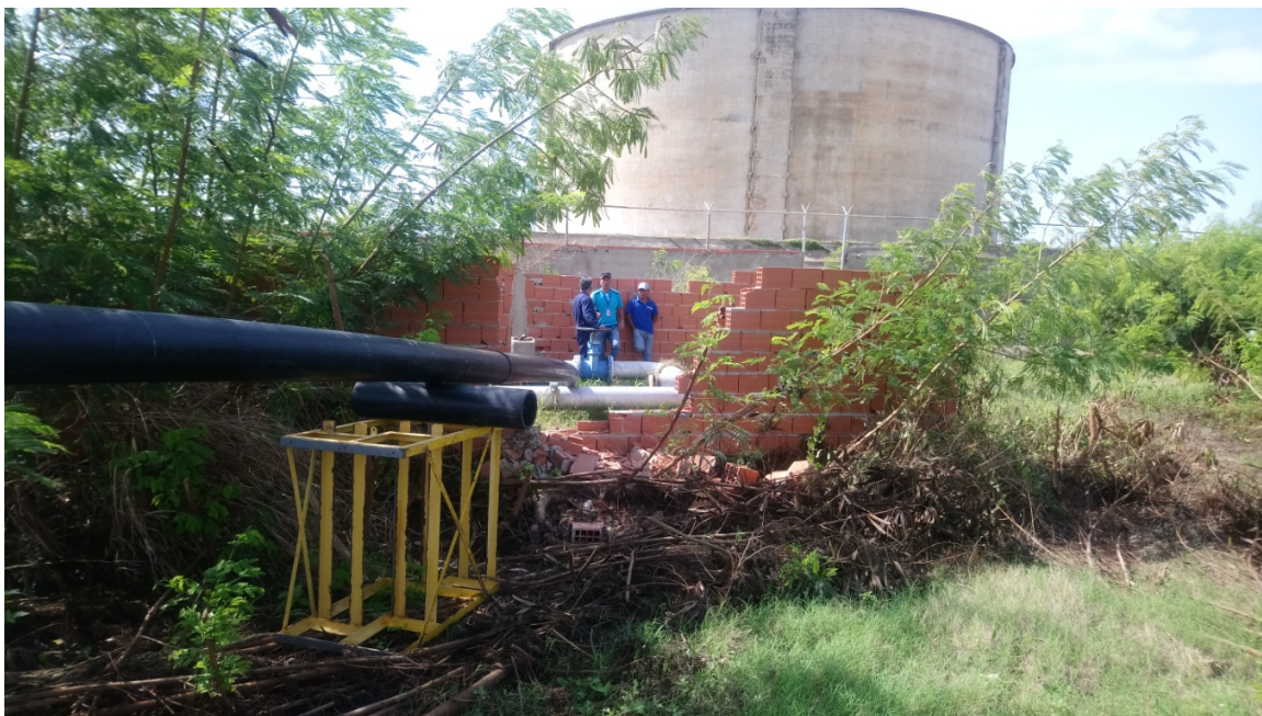
Línea del By Pass o salto de 8" , E.B.L.O.S.
