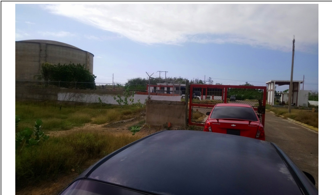
Entrada principal de La Estación de Bombeo Los Olivos (EBLOS) ubicada en la población de Tacuato Municipio Carirubana. Punto de recepción y distribución del agua potable a Paraguaná
