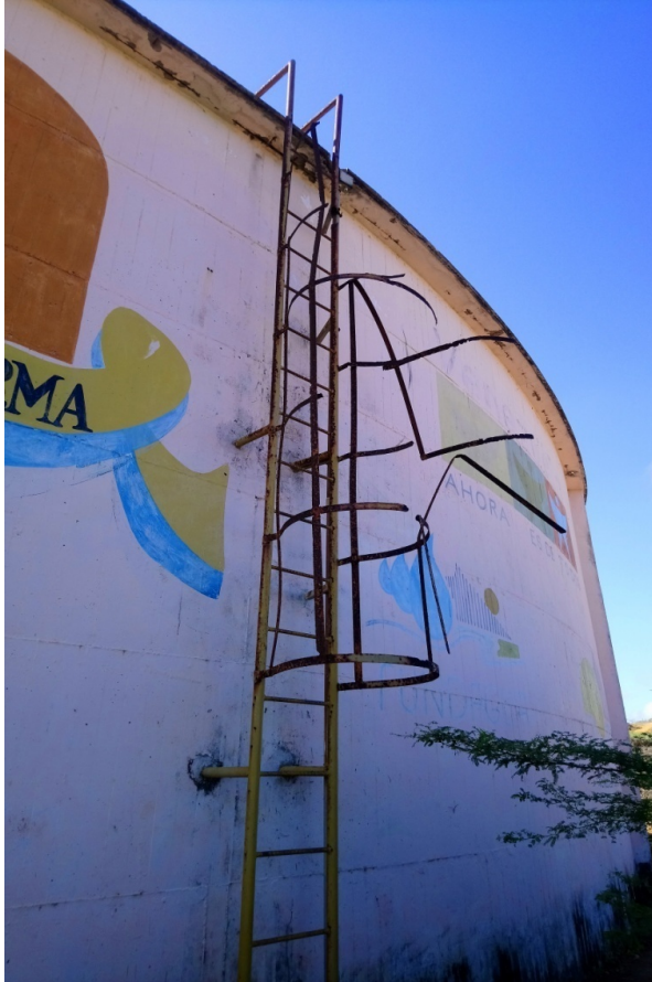
Escalera de acceso presenta daños en los peldaños y la estructura de protección.
