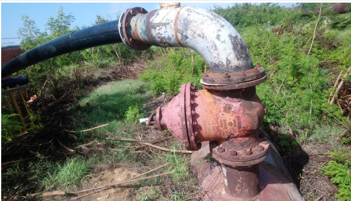
Removida ventosa de 10" para instalación de By-Pass hacia el Municipio Falcón debido a falla en la válvula anterior.
