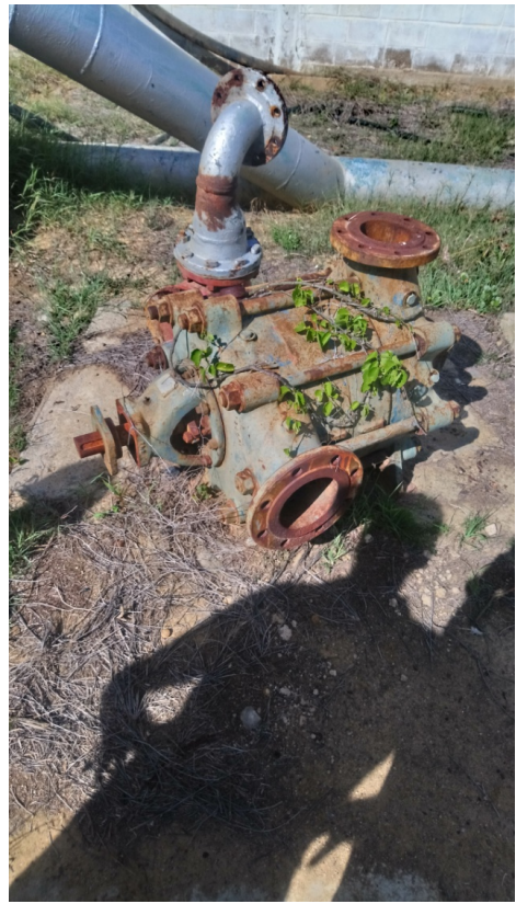
Líneas y spools con avanzado grado de deterioro, a la derecha vemos una bomba parcialmente desarmada y sin protección.
