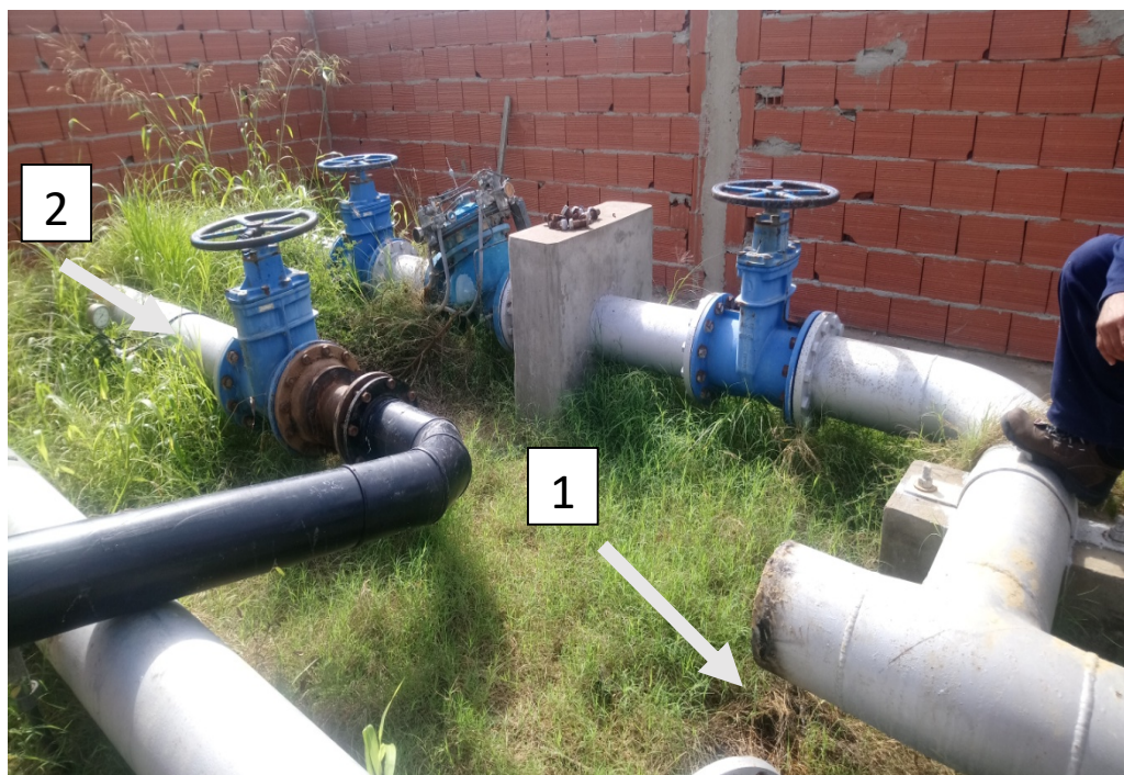
Corte de la línea original para construir el By Pass (1), se reemplazó válvula de 8" (2) que presentaba daños internos por pase permanente al Municipio Falcón.
