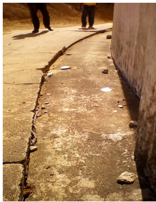
Desnivel en la parte inferior del tanque que amerita una inspección profunda para determinar si es un hundimiento
