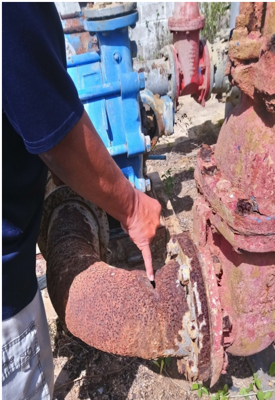
Líneas y spools con avanzado grado de deterioro, a la derecha vemos una bomba parcialmente desarmada y sin protección.
