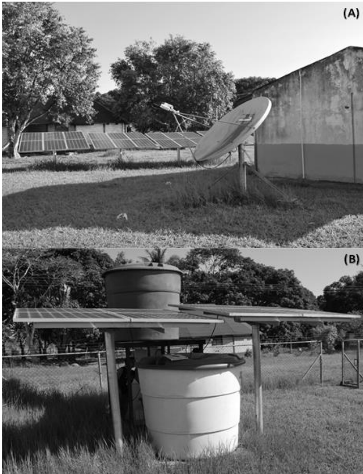
Figura 39 (A) Centro de Telecomunicaciones; (B) Planta de Agua electrificados con sistemas solares fotovoltaicos comunitarios
