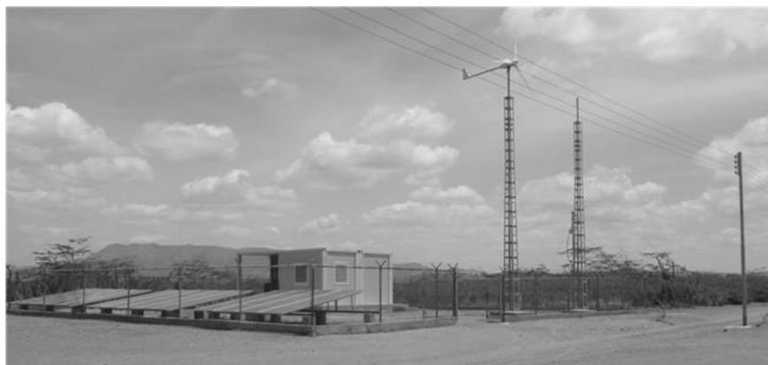
Figura 23 Sistema híbrido de la microrred rural de Macuïrrapa. En la fotografía se observa que el aerogenerador de 3 kW ha sido desmontado para mantenimiento.
