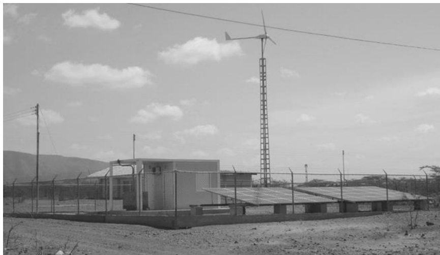
Figura 25 Sistema híbrido de la microrred rural de Poolos
