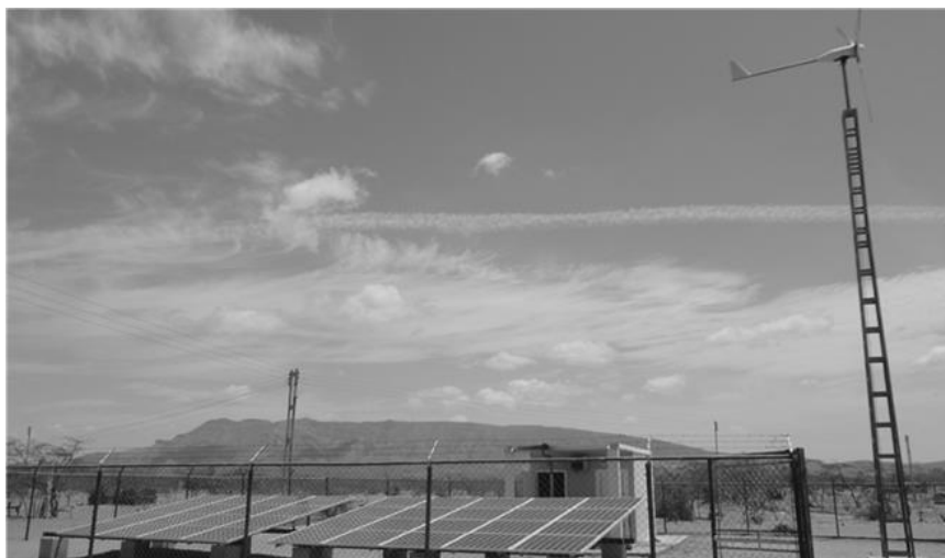
Figura 28 Sistema híbrido de la microrred rural de Taparo
