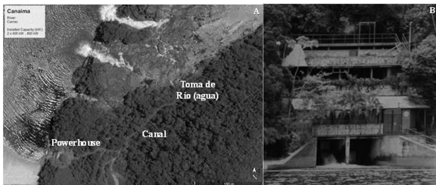
Figura 51 (A) Imagen satelital de la micro central hidroeléctrica de Canaima (B) Powerhouse
