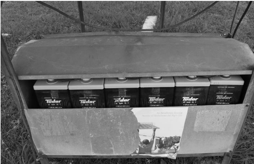
Figura 59 Sistema de almacenamiento de energía en baterías de plomo-ácido con una capacidad de 12 \times 490 A-h con baterías 7 OPzS del fabricante Tudor para un SFV de 1200 Wp
