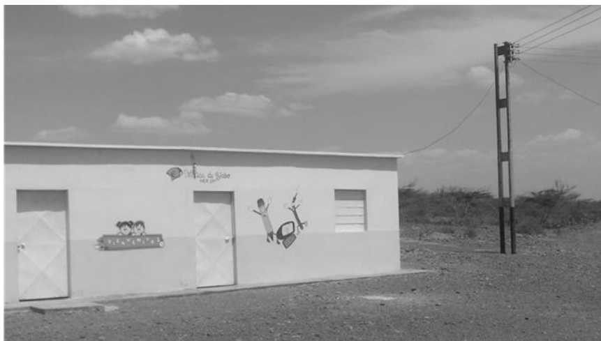
Figura 14 Escuela Básica de “Los Arroyos” electrificada a través de la red en 120 V de la microrred rural híbrida de la comunidad
