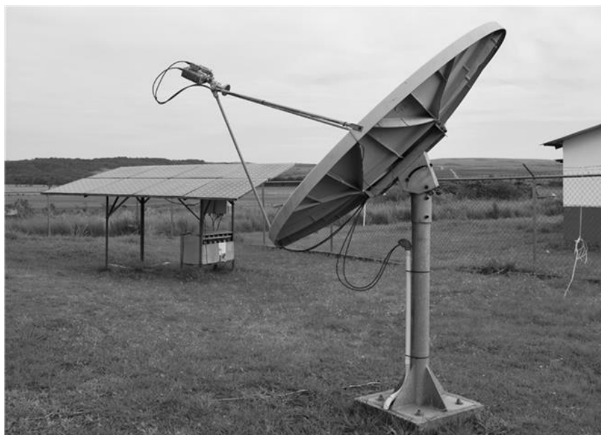
Figura 40 Sistema de 1200 Wp para electrificación del ambulatorio de la Comunidad de San Rafael de Kamoirán y acceso a internet en las instalaciones de este.
