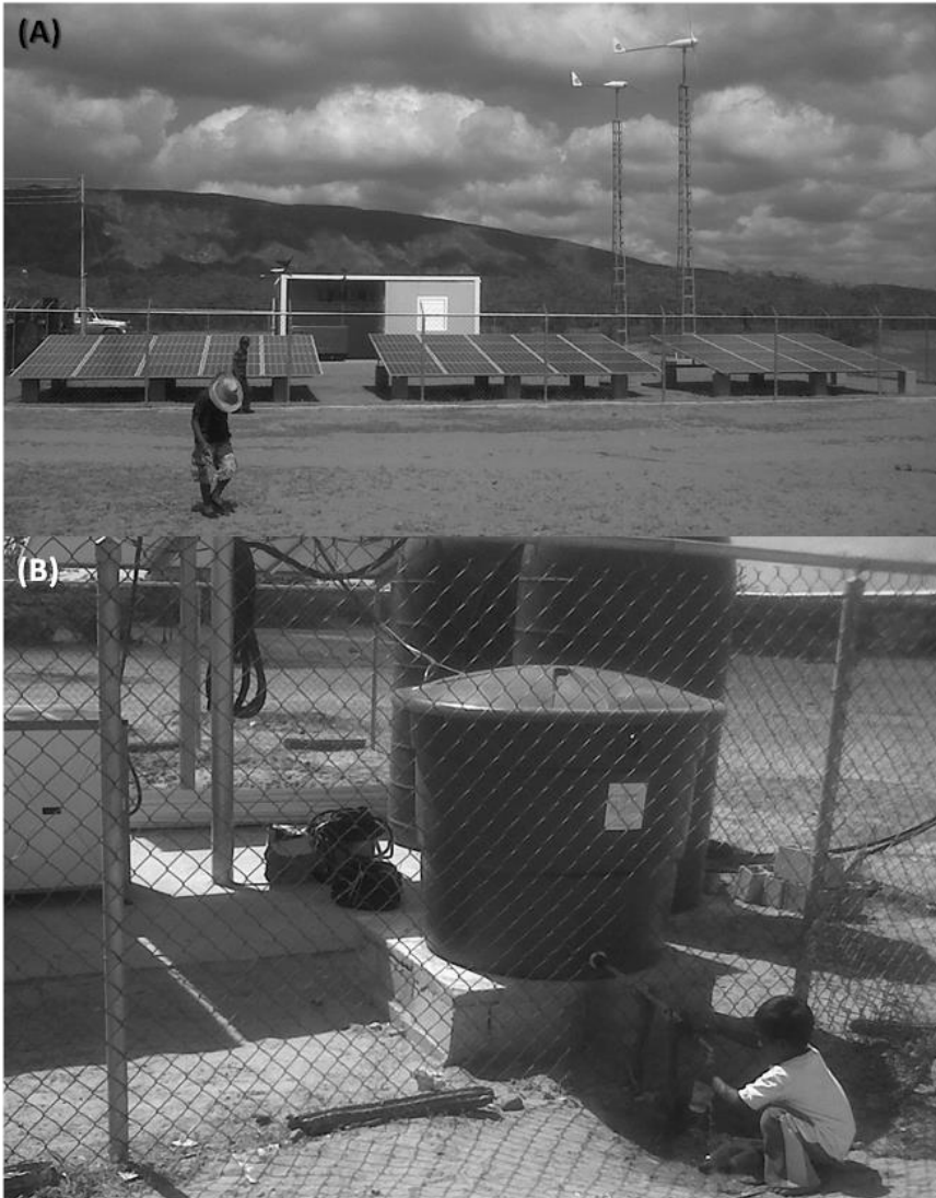
Figura 29 (A) Sistema híbrido de la microrred rural de Wososo; (B) Planta desalinizadora y potabilizadora de agua con energía solar fotovoltaica (SFV-1200) en Wososo
