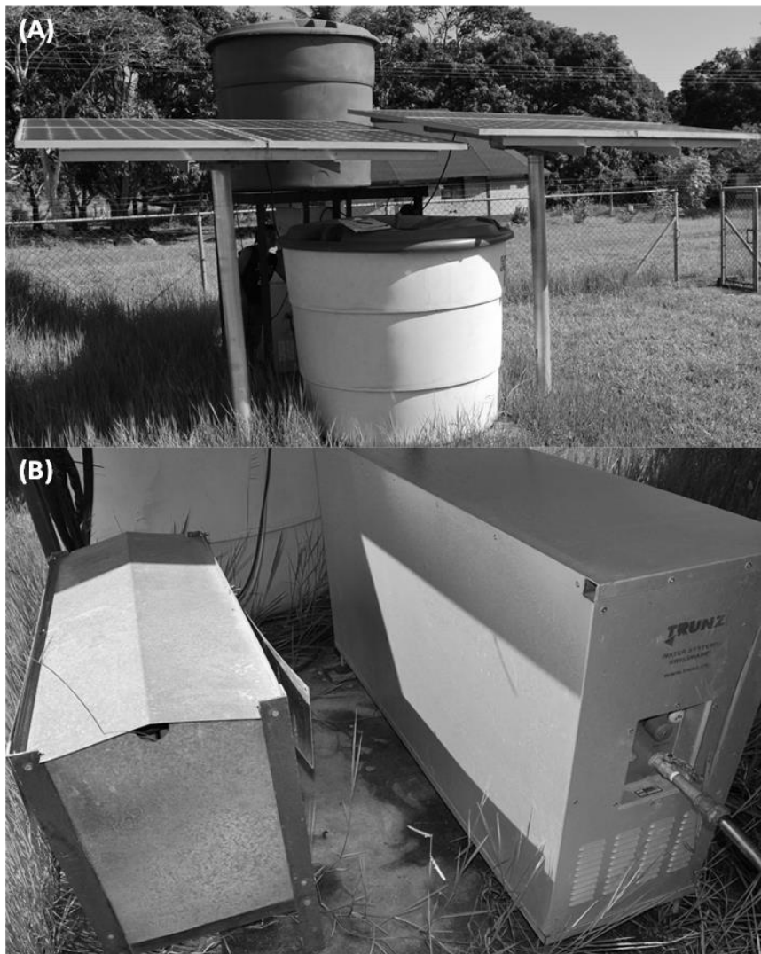
Figura 58 (A) Módulo solar fotovoltaico de 1200 W p y tanque de almacenamiento de agua y (B) Baterías y planta de tratamiento de agua, en la comunidad rural de Santa Cruz e Mapauri en La Gran Sabana (Estado Bolívar)
