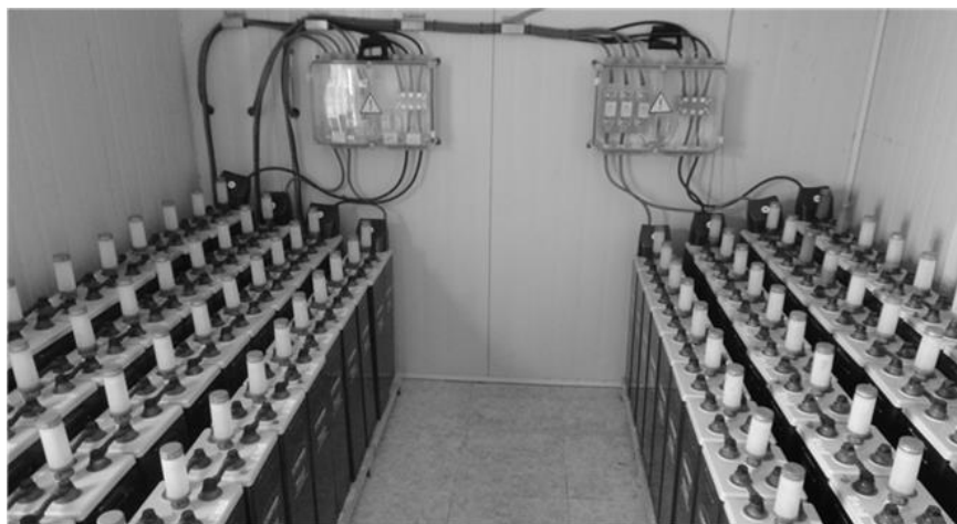
Figura 27 Sistema de almacenamiento en baterías del sistema híbrido de Cúsia
