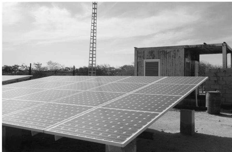
Figura 26 El Sistema Híbrido de Castilletes evidencia altos niveles de corrosión debido a la salinidad de la zona costera y las elevadas velocidades de viento en la Guajira venezolana
