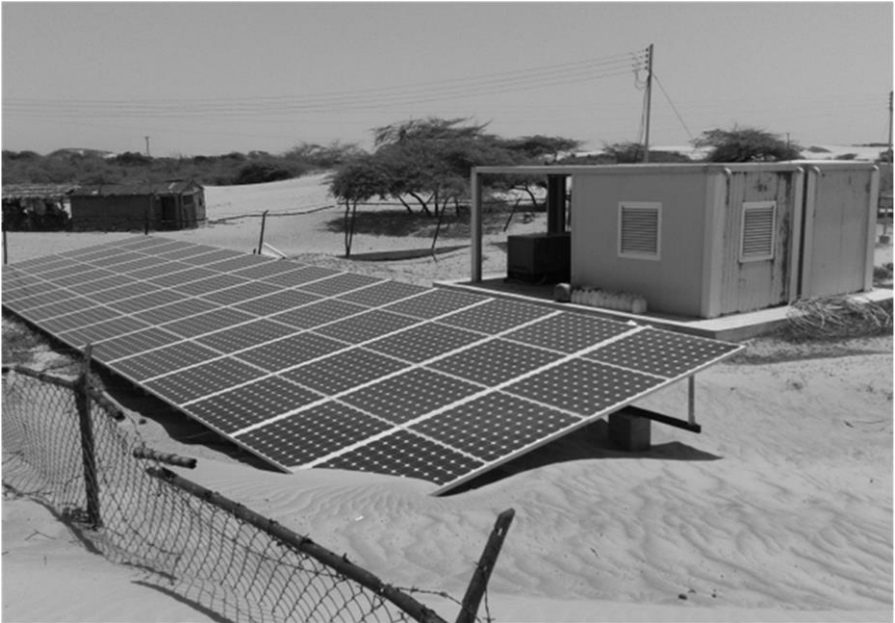
Figura 30 Módulo solar fotovoltaico del sistema híbrido de la microrred rural de Punta Manglar inmerso en arena debido a la falta de mantenimiento de los operadores comunitarios
