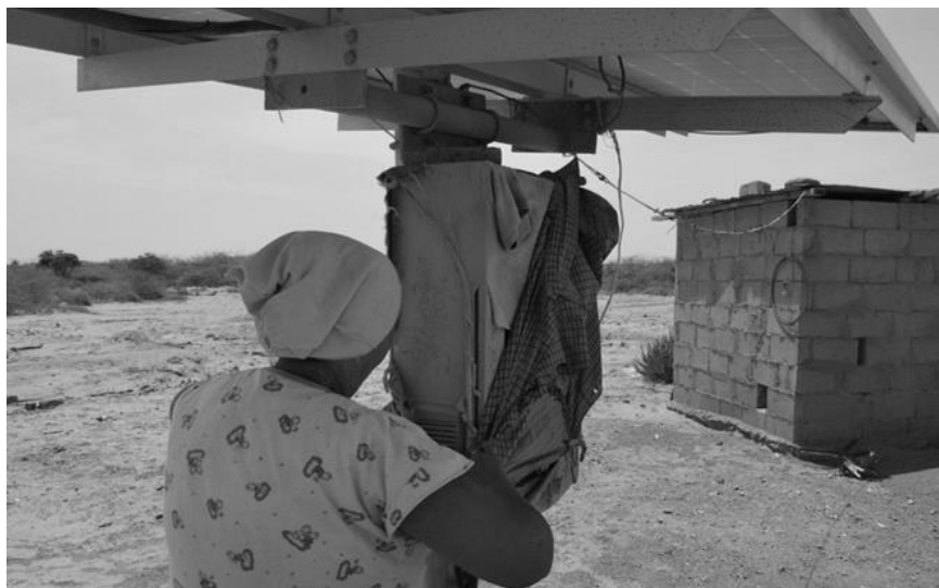
Figura 15 . Usuaría de SFV-600 en Matica de Yabo, recubre el inversor y baterías con trapos para protegerlos de los intensos vientos salinos de la costa que provocan severa corrosión
