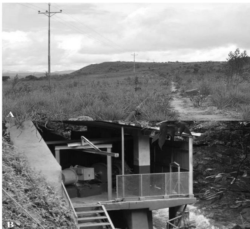
Figura 48 (A) Líneas eléctricas y de agua de Apacairo; (B) Micro central hidroeléctrica de Kavanayen
